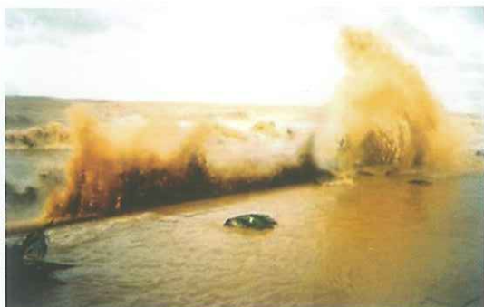
Đê biển Đồ Sơn, Hải Phòng bị sóng tàn phá trong cơn bão số 2 năm 2005 do không có RNM bảo vệ Sea dyke system without mangrove buffers was destroyed by large waves of the typhoon No.2 in 2005 in Do Son Beach, Hai Phong City.
