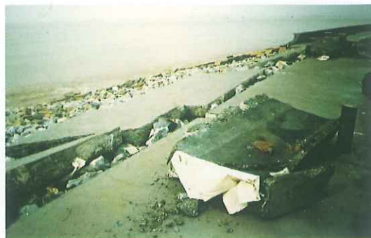
Đê biển Đồ Sơn, Hải Phòng bị sóng tàn phá trong cơn bão số 2 năm 2005 do không có RNM bảo vệ Sea dyke system without mangrove buffers was destroyed by large waves of the typhoon No.2 in 2005 in Do Son Beach, Hai Phong City.
